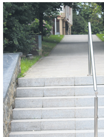
Mirentxuko eskailera. TXINTXARRI
