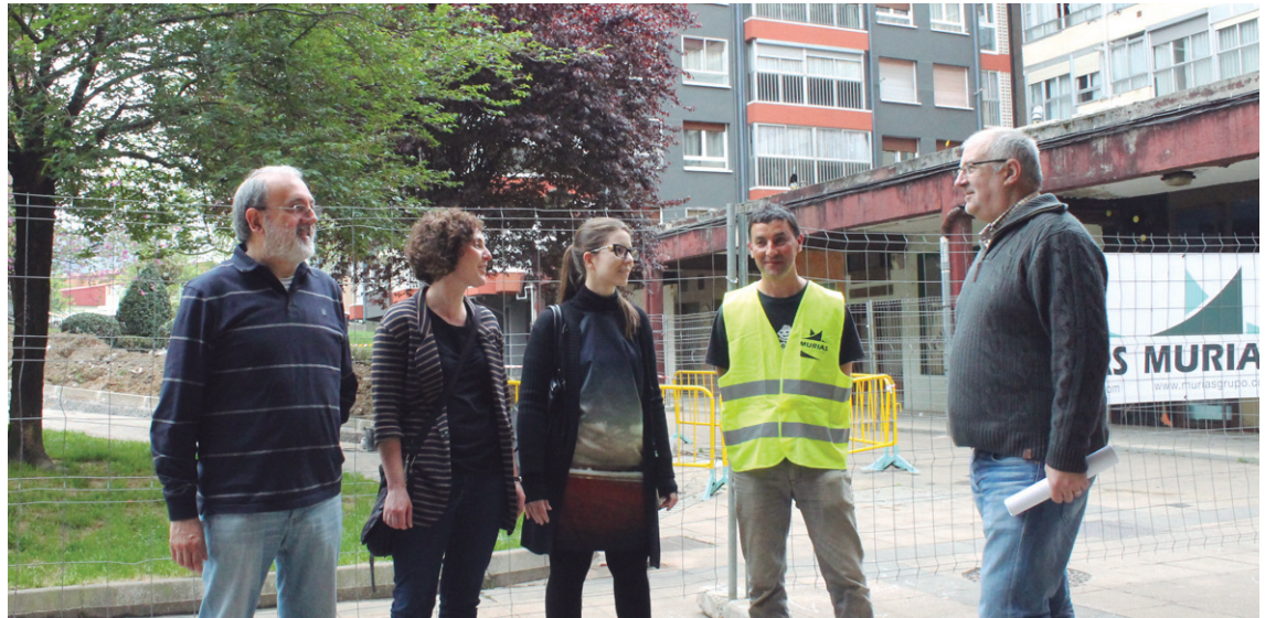
Udal ordezkari eta teknikariak, Muriaseko obra arduraduna eta Hiridunak talde teknikoko kidea lanen eremuan.
