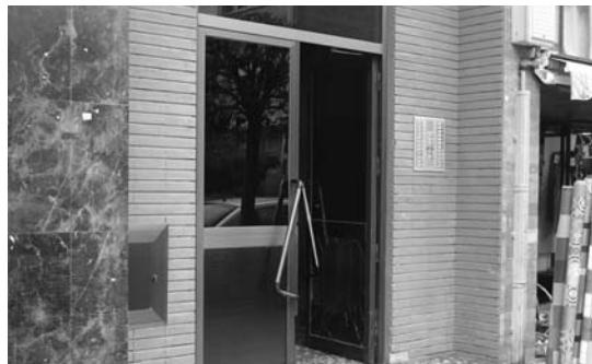
Atea puskatu zuen erasotzaileak etxebizitzara igo ahal izateko.
